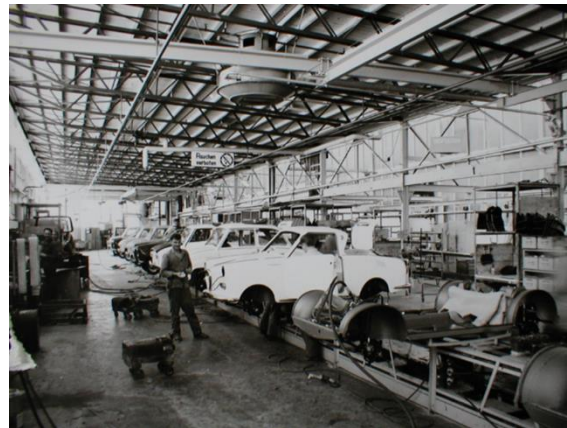
Bild 5: 1960 – Magnesia Industrieboden in der Glas Gogomobilfabrik, Dingolfing, heute BMW.
